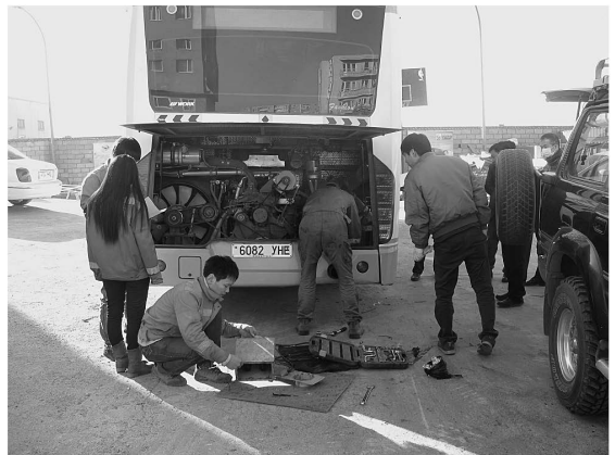
モンゴルでの計測装置設置作業時の様子
