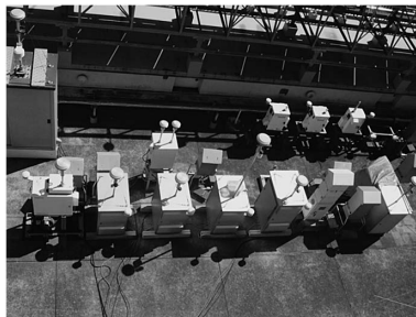
写真2 研究所屋上の大気観測機器
