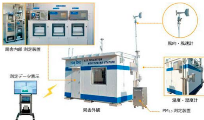
環境大気測定コンテナ局舎
