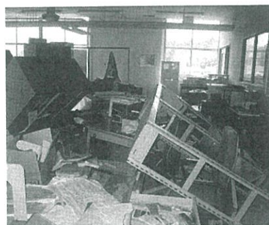
被災後の室内(1)
