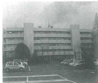
被災後の本庁舎
