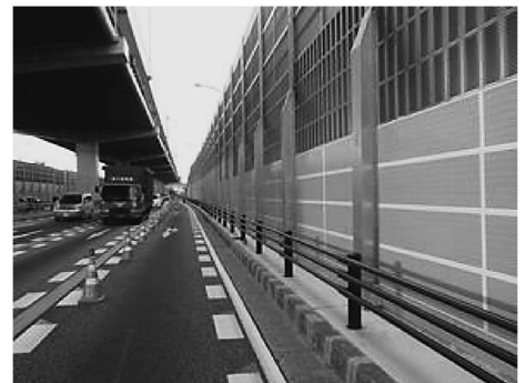
名古屋市国道23号に設置された ACF大気浄化吸音板（NCCパネル）
