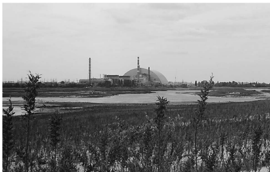
図3 2016年11月に巨大シェルタの移設作業が終了したチェルノブイリ原発。写真の手前は冷却水供給池の水位低下により露出した堆積物。
