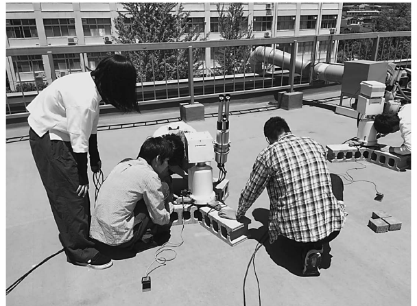
山梨大学屋上での機器設置作業
